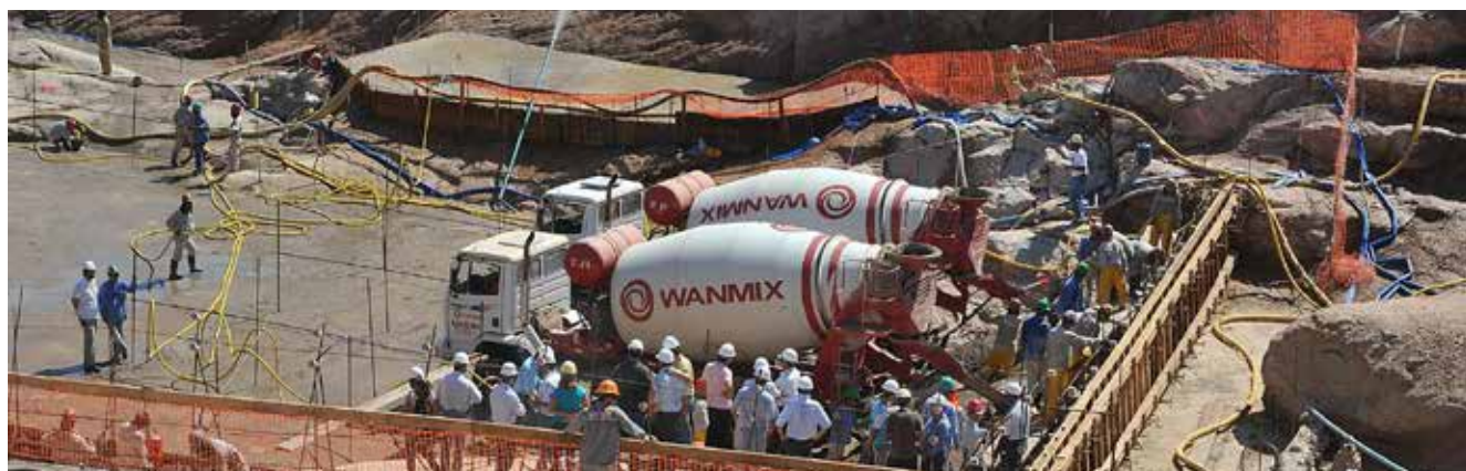
Obras da usina hidrelétrica de Santo Antônio, no rio Madeira, em 2009. As barragens no Madeira interromperam rotas de migração de grandes bagres.
